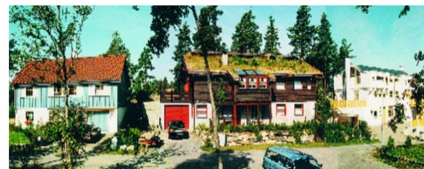
Hvert enkelt hus har en grei utforming, men med stor ulikhet i stil, materialvalg og farge danner de et noe anstrengende helhet.
